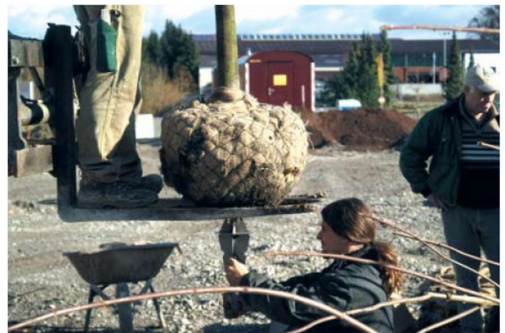
Mit drei Hammerschlägen sitzt der Doppelspieß als Pfahlwurzel im Kugel-Ballen.
